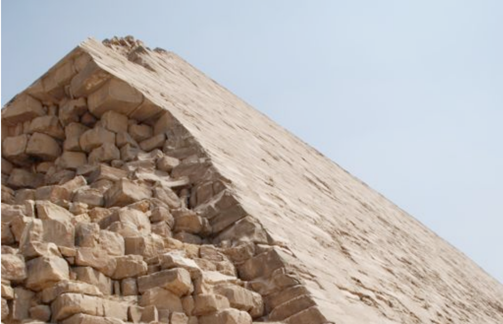
Der Kern der Pyramide besteht aus waagrecht verlegten, unregelmäßigen Steinblöcken.
