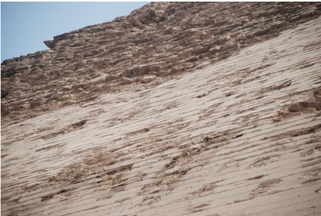
Im oberen Teil der Pyramide wurde nicht nur der Winkel geändert, sondern auch die Bauweise: Die Verkleidungssteine wurden nicht mehr mit 15° Neigung nach innen verlegt, sondern waagrecht. Diese Methode war offensichtlich erfolgreicher und sollte bei allen späteren Pyramiden zur Anwendung kommen.
