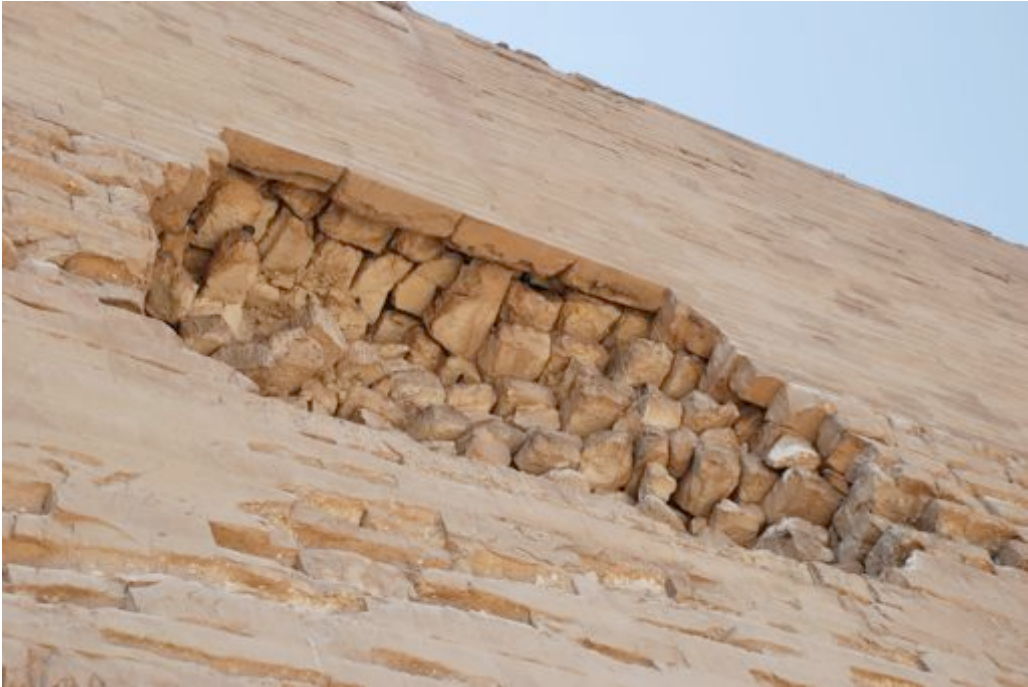
Der stufenförmige Kern wurde noch in der klassischen Läufer-Binder Methode gebaut.
