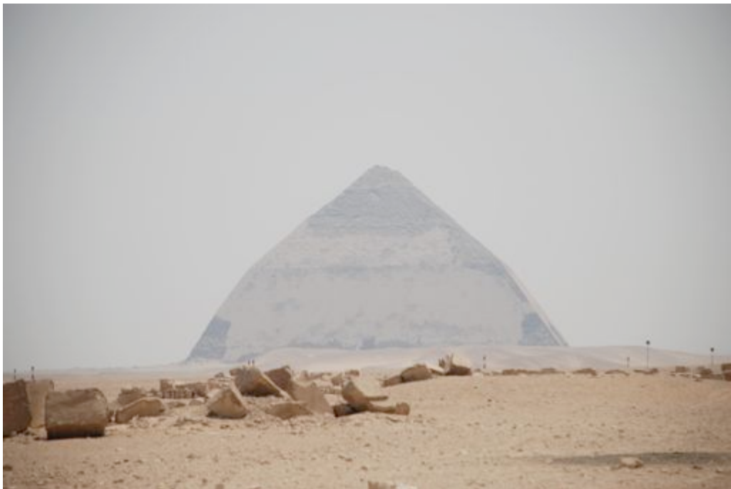
Die Knickpyramide von Dashur: Der obere Teil der Pyramide weist einen geringeren Neigungswinkel auf. Als Ursache dafür wird gemeinhin eine Instabilität des unteren Baukörpers vermutet, die schon während des Baus aufgetreten sein soll. Dennoch erhöhten die ägyptischen Baumeister die Pyramide um weitere 50 m.
