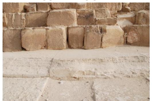
Die Steine der Cheopspyramide: Sie sind unterschiedlich groß. Wurden in den unteren Schichten noch Blöcke mit 1,2 m Höhe verbaut, so werden sie mit zunehmender Pyramidenhöhe immer kleiner. Die Steine an der Spitze sind nur mehr 50 - 60 cm hoch.
