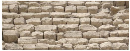
Auch bei den ersten Pyramiden wurde diese Technik des Mauerbaus verwendet, wie hier bei der Pyramide des Djoser in Sakkara.
