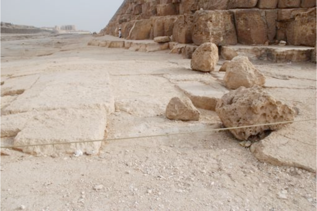
Die Westkante der Cheopspyramide: Sie ist auf 2,8 Bogenminuten genau nach Norden ausgerichtet. Auf 230 m Länge bedeutet das eine Abweichung von 19 cm.
